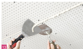
13 Odstranit ztvrdlý tmel
