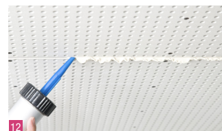
12 Zatmelit šrouby a spáry s mírným převýšením
