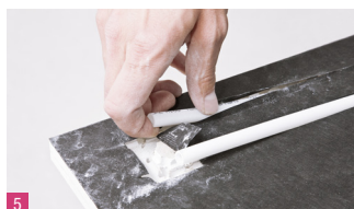
5 Potrubí vyjmout a napojit na rozdělovač
