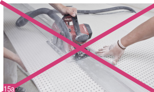
15a Zkracování nebo úprava je možná pouze u slepých desek, nikdy neřežeme desky s potrubím!
