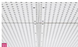
11 Vyrovnání desek dle vzoru díry
