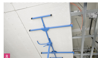
8 Montáž desek pouze s montážním výtahem
